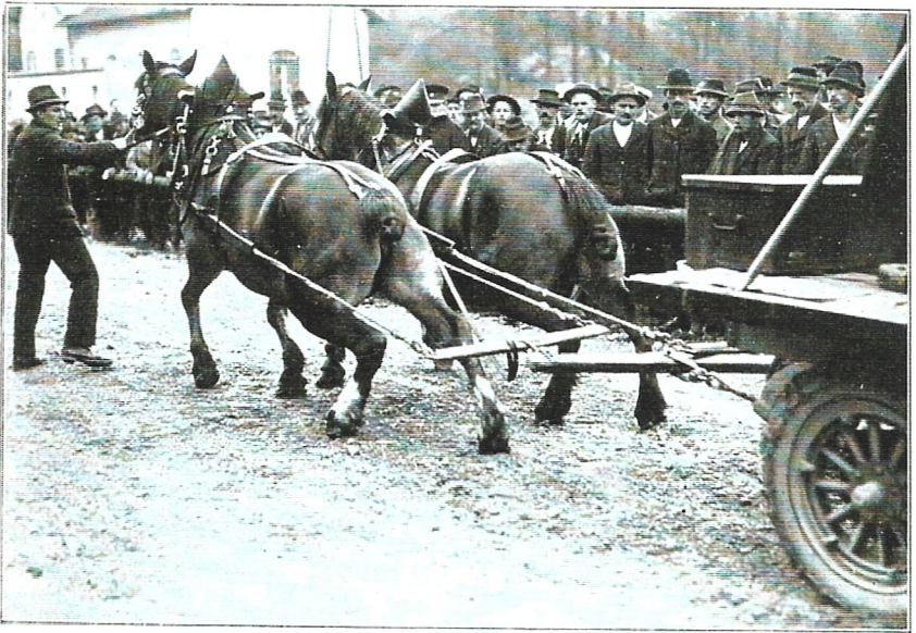
Zugleistungsprüfung am amerikanischen Zugkraftmestwagen
